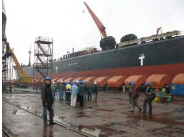
Reparaciones banda babor Arturo U. Illia
